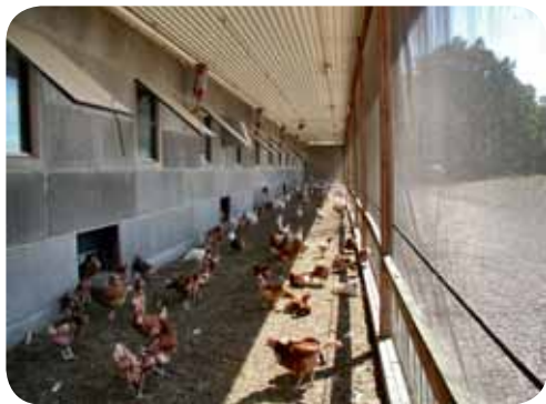
Fönsterluckorna på huset gör det möjligt att reglera ljusinsläppet.
